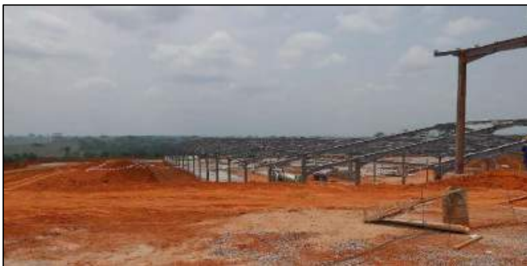
Figure 8. Chantier de construction de la nouvelle usine
